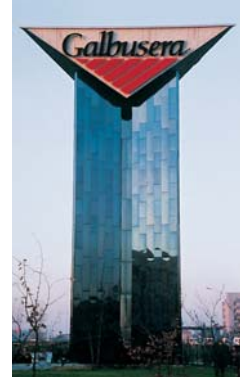
İtalya, Agrate Brianza'da (Milan) şekerli yiyecek üreten bir şirketin logosu, elektrolitik olarak renklendirilmiş paslanmaz çelik ile kaplı, 22 metre yüksekliğinde bir kule ile desteklenmektedir.
